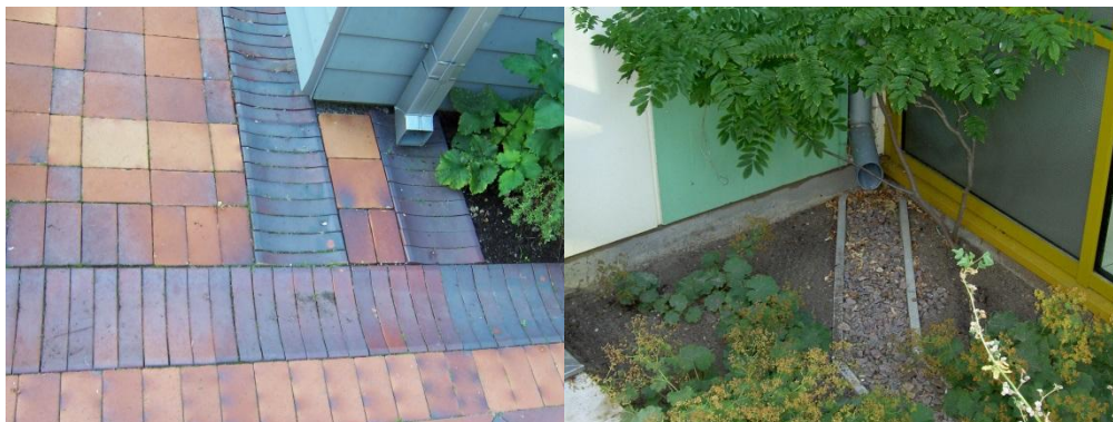
Figur 12. Inspirationsbilder vattenutkastare/rännor för avledning (foto: Rambøll).
