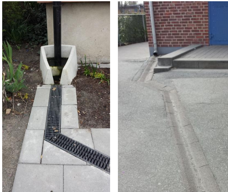
Figur 13. Fler inspirationsbilder för grunda rännor för stuprör med utkastare (foto Ramböll)
