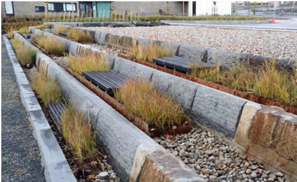
Figur 15. Exempel på filter och fördröjningsanläggning i lutande terräng.
